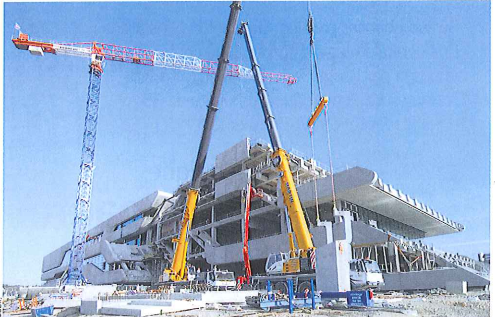
Du Nord vers le Sud, le bâtiment des Pierres Vives se développe sur une longueur de 200 m pour 47 m de large et 26 m de haut.
