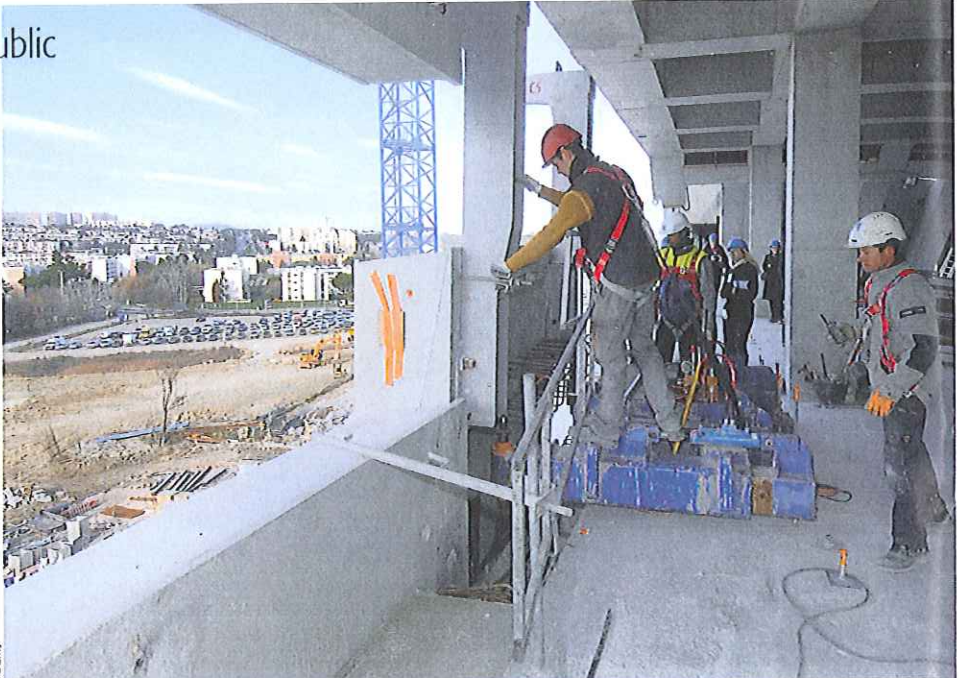
Pose d'un élément de façade : les potences fixées à l'arrière du panneau sont sur le point d'être accrochées sur les têtes de vérins de réglage en Z.
